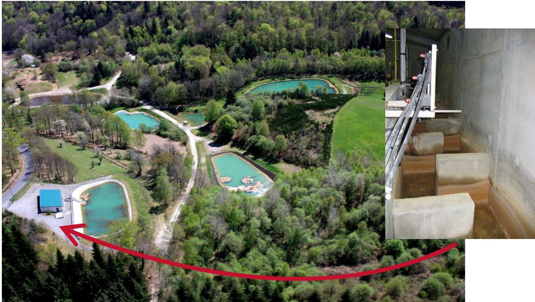
Station de traitement des eaux d'Augères (87)
